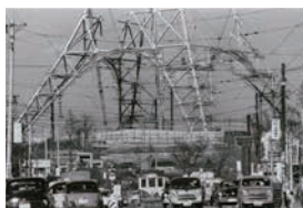
林忠彦《東京タワー建設》1958(昭和33)年
